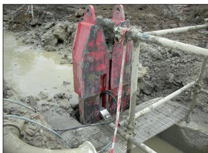
Il Tubo Spalla viene staccato dal calcestruzzo (si notano i tubi idraulici)
