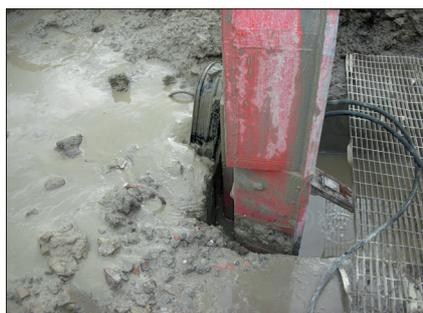
Particolare del distacco del Tubo Spalla a mezzo martinetti idraulici
