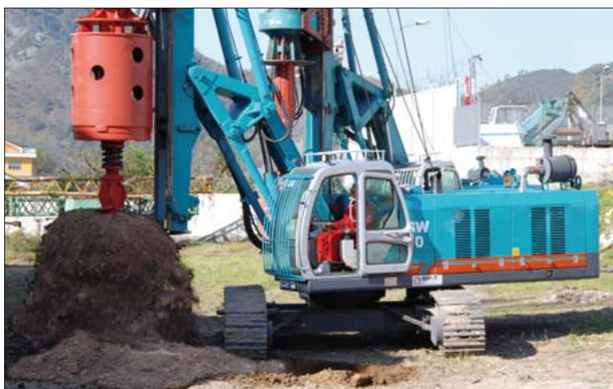
La rotary è dotata di un sistema ammortizzante per attutire le elevate sollecitazioni sviluppate dal kelly bar
