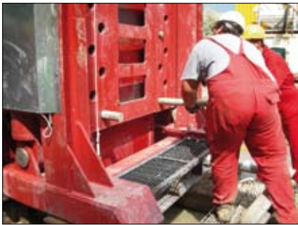
Inserimento degli spinotti per la fase di estrazione
