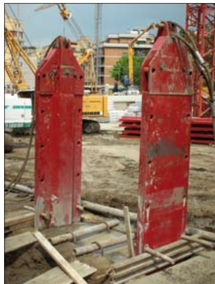
Tubi spalla infissi nel terreno
