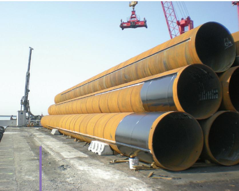
I singoli elementi sono realizzati in modo da avere due binari disposti a 180° utilizzati, nella fase successiva di discesa delle palancole, per unire tra loro i lamierini e creare un isolamento idrico.
