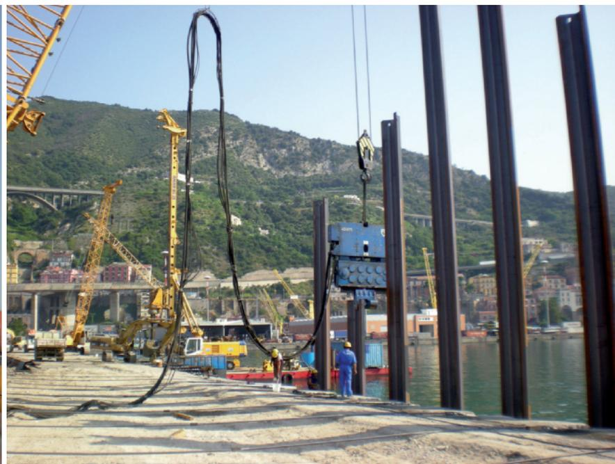
**Per la vibroinfissione dei lamierini e delle palancole la CGX utilizza una gru cingolata Liebherr HS 895, dal peso operativo di 173 t. Per i lamierini il vibratore è un PVE 110 M (momento eccentrico 110 kgm, frequenza massima 1.350 tpm, forza 2.250 kN e pressione massima 350 bar), mentre per le palancole è un PVE 40 VM (momento eccentrico 40 kgm, frequenza massima 2.000 tpm, forza 1.750 kN e pressione massima 350 bar).**
