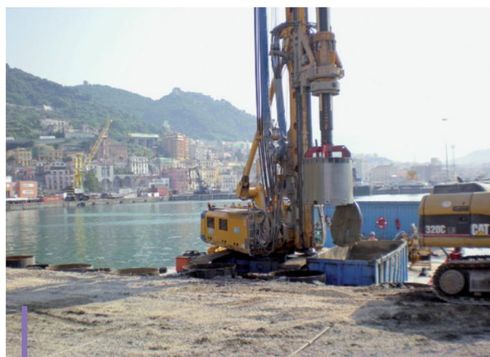
**Sip&T ha realizzato un bucket da roccia dotato di un fondo girevole in acciaio speciale, di adeguato spessore con le lame in acciaio speciale, disegnate con un profilo spezzato ed equipaggiate con i taglienti disposti in particolari posizioni e inclinazioni per garantire una loro rapida sostituzione, ma soprattutto un contatto progressivo e ottimale con la superficie rocciosa.**
