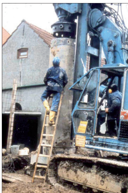
Avvitamento e fissaggio della colonna rivestimento al trascinatore utilizzando una scala
