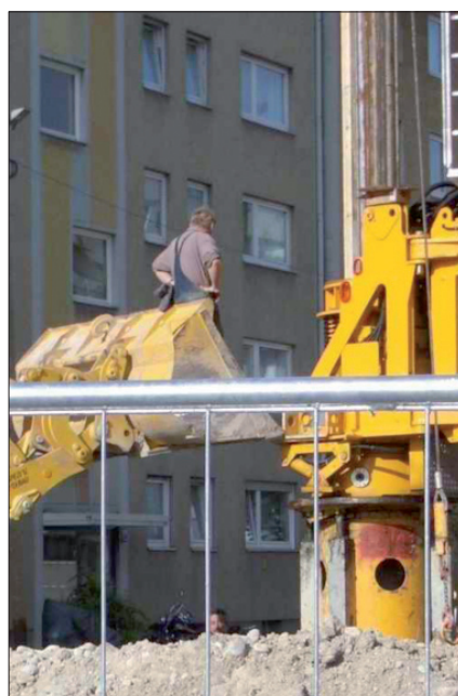
L'uso di una pala gommata come "piattaforma di lavoro" e imbracatura di fortuna sono esempi di mezzi d'accesso inadeguati
