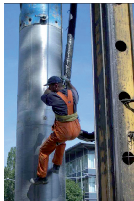
L'uso di una pala gommata come "piattaforma di lavoro" e imbracatura di fortuna sono esempi di mezzi d'accesso inadeguati
