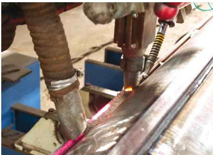
▲ PROCESSO DI SALDATURA A FILO CONTINUO CON TECNICA AD ARCO SOMMERSO SOTTO PROTEZIONE DI SCORIA. PERMETTE DI OPERARE CON ELEVATE VELOCITÀ, È COMPLETAMENTE AUTOMATICO CON QUALITÀ DELLE SALDATURE ELEVATA RISPETTO A QUELLE MANUALI
